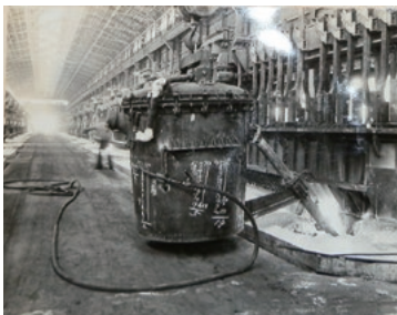
炉底アルミニウム吸い取り作業
