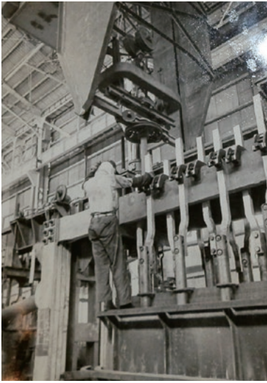
バーチカルスピック抜き作業
