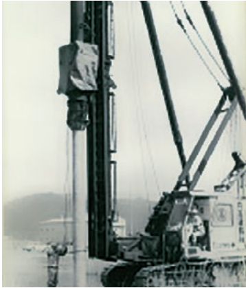
多喜浜工場建設
